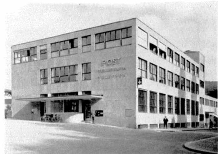
Am Bahnhofplatz sind 2 Eingänge unter dem weitausladenden Vordache, je seitlich des Warteraumes für Postpassagiere. Vom Warteraum gelangt man direkt zu den Schaltern. Links befindet sich der Fächerraum mit Schreibgelegenheit, rechts das Telegraphenamt mit 3 öffentlichen Sprechstationen.
